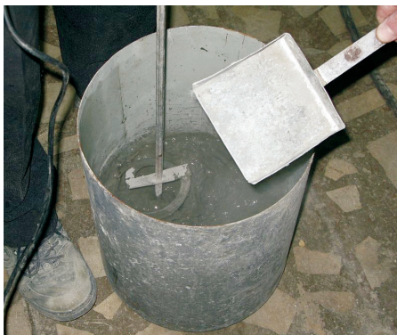
Рисунок П1 Приготовление ремонтного состава Maregrout Thixotropic
