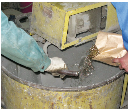
Рисунок П2 Приготовление ремонтного состава АРБ-10Ф в растворосмесителе принудительного действия
