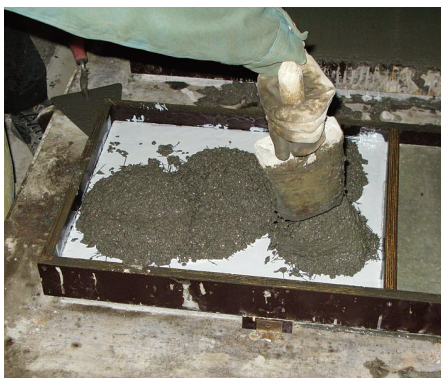
Рисунок П4 Укладка ремонтного материала АРБ-10Ф
