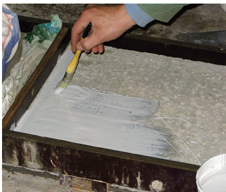
Рисунок П3 Нанесение адгезионного состава марки EpoGrp на поверхность бетонного основания
