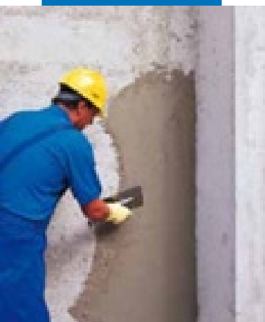
Нанесение шпателем
