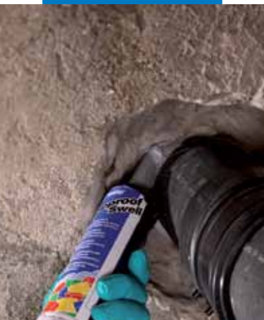
Герметизация элемента при помощи Mapeproof Swell
