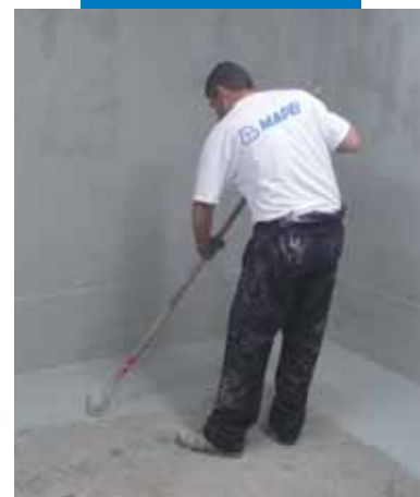
Нанесение Mapelastic Foundation валиком для гидроизоляции при эксплуатации с отрицательным давлением воды
