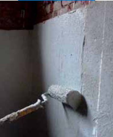
Нанесение Mapelastic Foundation валиком на основание выровненное Planitor HDM Maxi
