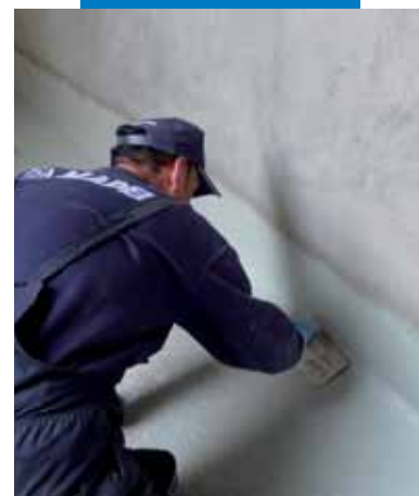
Нанесение Mapelastic Foundation шпателем для гидроизоляции при эксплуатации с отрицательным давлением воды
