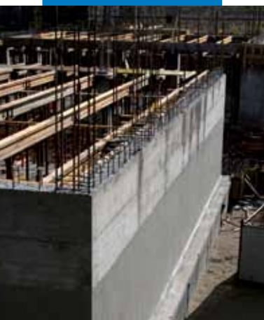
Нанесение гидроизоляции Mapelastic Foundation на подпорную стену после заливки
