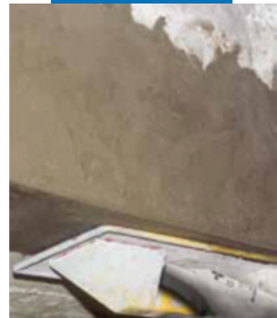
Локальный ремонт бетонной балки
