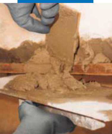
Восстановление фасадной бетонной плиты балкона: нанесение Planitop 400
