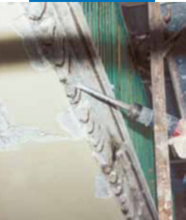
Восстановление фасадной бетонной плиты балкона: подготовка основания
