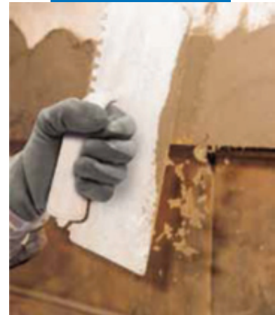
Восстановление фасадной бетонной плиты балкона: отделка
