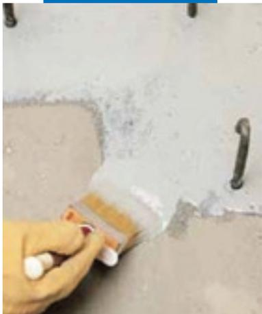
Нанесение **Eporip** кистью на рабочий шов бетонирования
