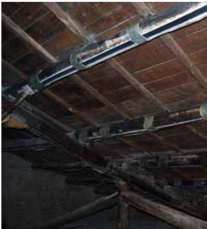
Усиление на изгиб для деревянных балок с использованием Carboplate, пластин из углеродных волокон, таких, как:
