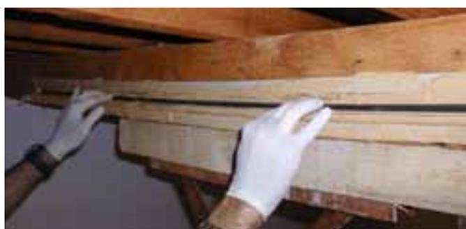
Усиление на изгиб для деревянных балок с использованием стержней из углеродного или прутков из стеклянного волокна, таких, как:
